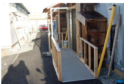
仮設住宅のバリアフリー。宮古市田老地区にて。
